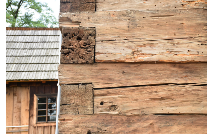
Figura 13: Encuentro de muros de madera Iglesia de Maloposka (2018).
