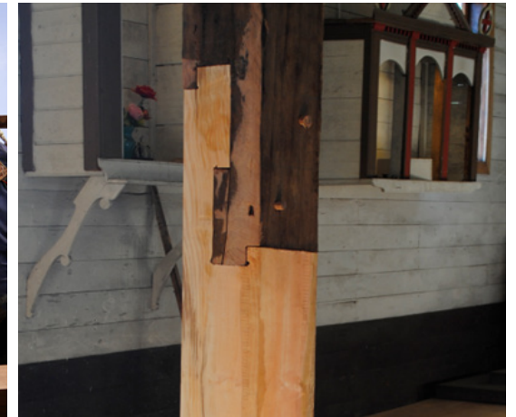
Figura 60: Empalme de llave con traba utilizado en restauración iglesia de San Juan, segunda versión. Fuente: Fernanda Subiabre (2021)
