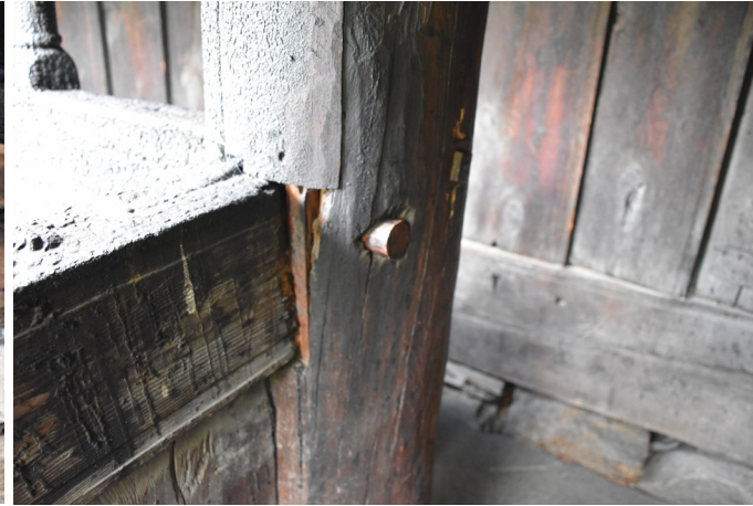
Figura 22: Encuentro con caja y espiga y refuerzo con tarugo en iglesia de Borgund, Noruega. (2018)
