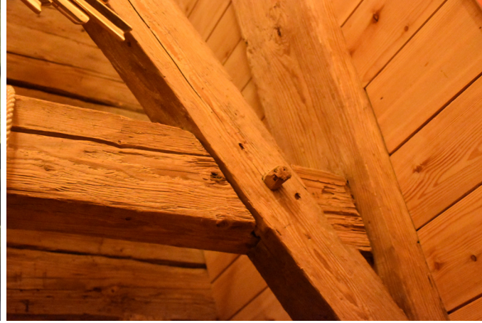
Figura 16: Detalle unión a media madera con tarugo en iglesia de Kosciol, Polonia. (2018)
