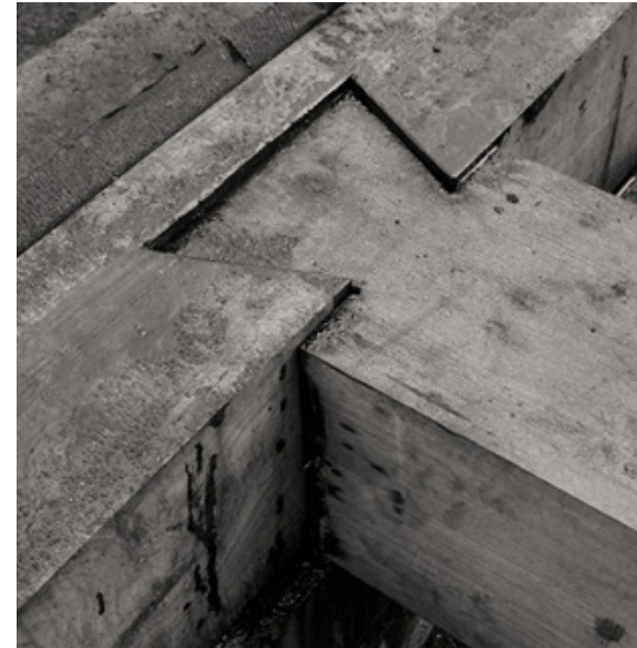
Figura 74: Ensamble cola de milano en iglesia de Dalcahue, Chiloé. (2013)
