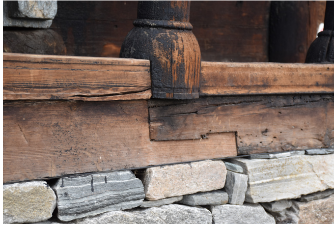
Figura 21: Unión empalme de llave en iglesia de Urnes, Noruega. (2018)
