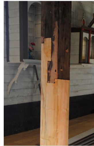
Figura 84: Unión empalme de llave en Chiloé. (2021)
