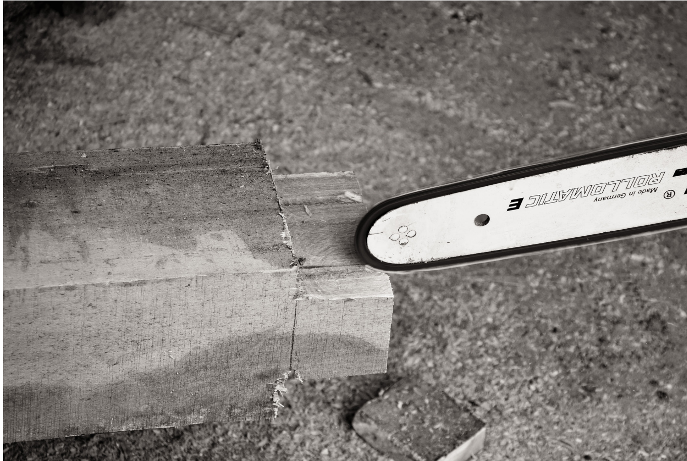
Figura 47: Proceso de construcción de ensamble espiga en pie derecho iglesia de Huyar Bajo, elaborado por carpintero tradicional con motosierra. (2017)
