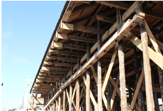
Figura 51: Iglesia de Nercón en proceso de restauración, sin pies derechos. (2012)
