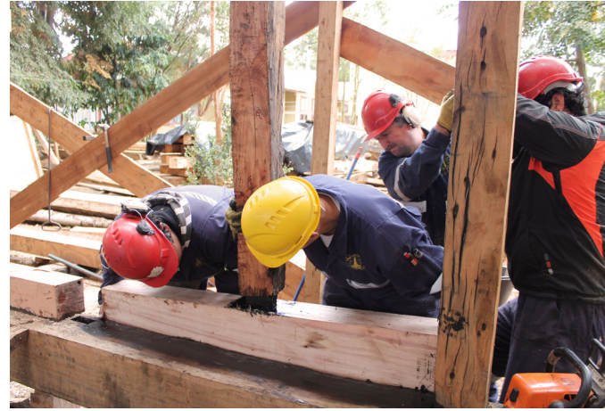
Figura 54: Proceso de instalación sobre solera en tabique, restauración Iglesia de Dalcahue. (2014)
