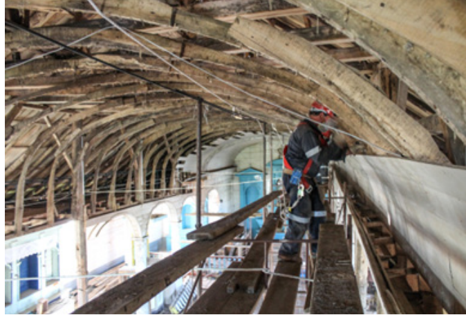
Figura 40: Proceso de restauración iglesia de Nercón donde se aprecia la estructura de cuadernas de la bóveda. (2012)
