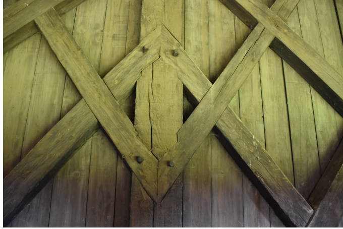
Figura 15: Entramado de tabique torre en iglesia de Haczow con sistema de ensambles. (2018)
