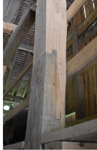
Figura 83: Unión empalme de llave en Suiza. (2018)
