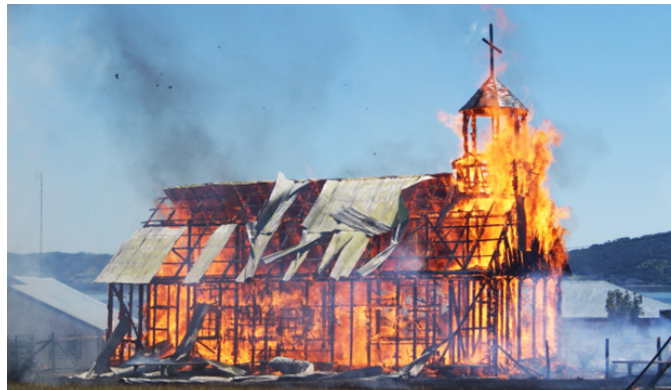
Figura 72: Imagen de incendio en iglesia San Juan de Chadmo el año 2013, donde se aprecia que, a pesar del avanzado estado de incendio, la estructura permanece en pie. Fuente: Araya (2017)
