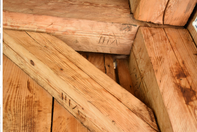
Figura 18: Encuentro de un nudo con ensambles y marcación con números romanos. Iglesia de Sekowa. (2018)
