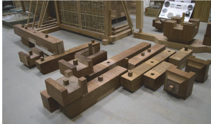
Figura 65: Partes desensambladas de Pagoda de Daigoji. Fuente: Okazaki (2019).
