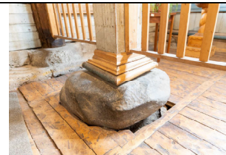
Encuentro de pilar y piedra de cimiento en iglesia de Achao
