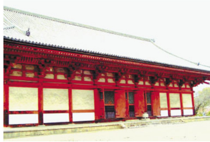
Figura 26: Fotografías sobre el sistema constructivo de poste y viga. Fuente: Shiratori (2008).
