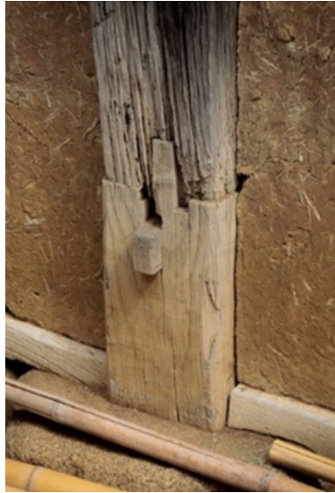
Figura 67. Unión de empalme utilizada en pie derecho en museo de Tokio, Japón. (2024)
