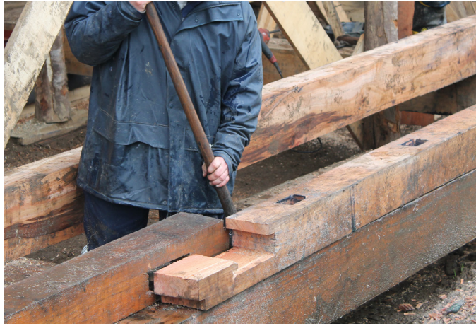
Figura 53: Proceso de instalación sobre solera en tabique, restauración Iglesia de Nercón. (2012)
