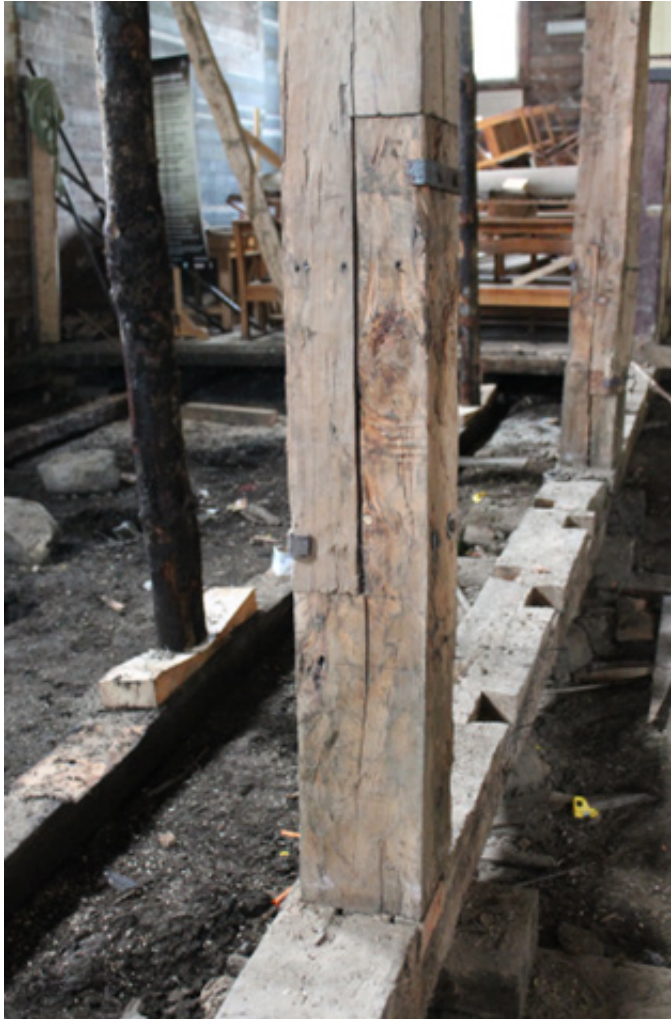
Figura 48: Pilar de columnata de nave central de iglesia de Dalcahue con refuerzos con zunchos metálicos. (2013)
