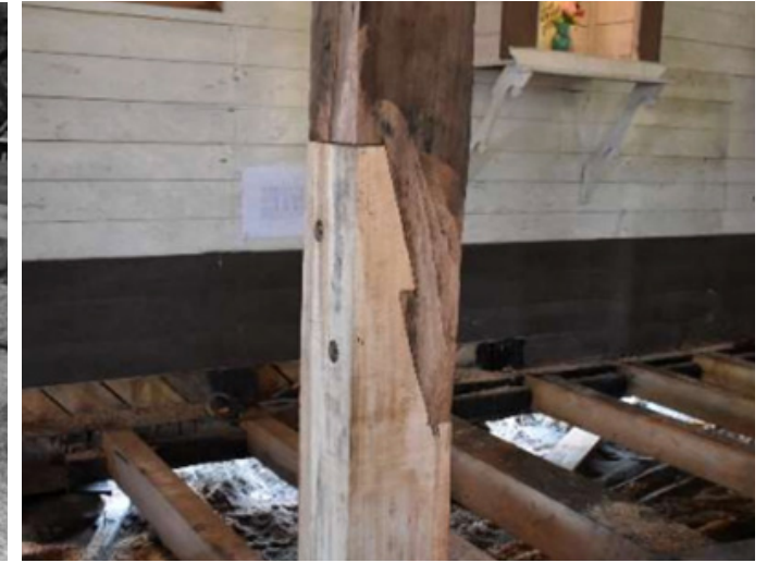
Figura 58: Rayo de Júpiter utilizado en restauración de iglesia de San Juan, primera versión. Fuente: Fernanda Subiabre (2021)
