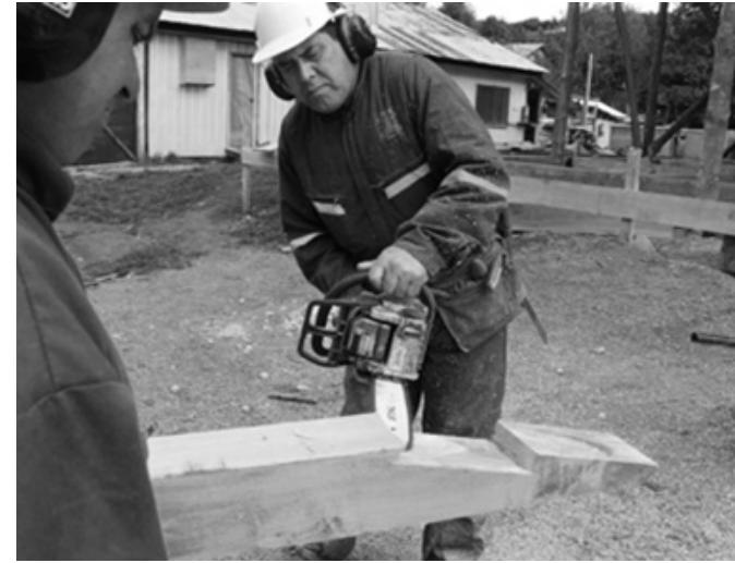
Figura 57: Proceso de elaboración empalme rayo de Júpiter en iglesia de Chelín. Almonacid (2018)
