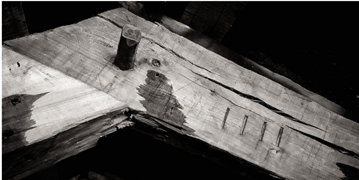
Figura 23: Unión par y nudillo (ensamble media madera con tarugo) en iglesia de Punucapa, Valdivia. (2017)
